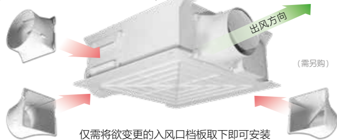
仅需将欲变更的入风口挡板取下即可安装 * 标准配备为出风口 1 件 / 入风口 1 件
