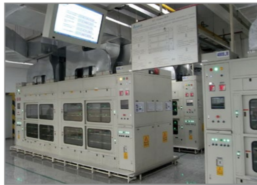
利用逆变器原理研发的能源回收器
