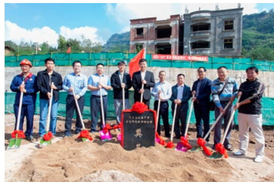
云南“大寨中学台达阳光教学综合楼”奠基开工
