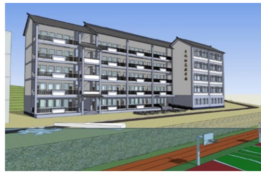
“大寨中学台达阳光教学综合楼”采用节能设计，抗震设防烈度8.0度
