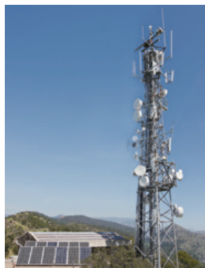
提供非洲電信營運商整合太陽能發電系統的戶外通信電源解決方案
