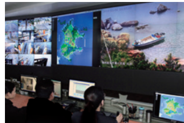
台達視訊解決方案提供平潭綜合實驗區環島監控系統
