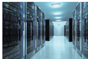
台達 InfraSuit 解決方案打造喀什地區第一人民醫院新建機房
