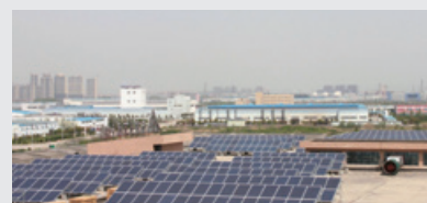
蕪湖廠區金太陽工程 -1.53MWp
