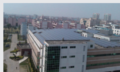
東莞廠區金太陽工程 -2.117MWp
