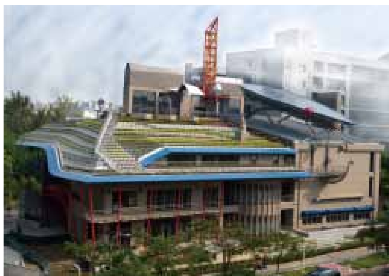
「孫運璿綠建築研究大樓」採用了 13 種綠建築設計手法，包括 5 種建築本體與自然通風的軟性節能手法、2 種設備減量的方法、5 種設備節能技術以及再生能源等技術，節能可達 65%，節水可達 50%。
