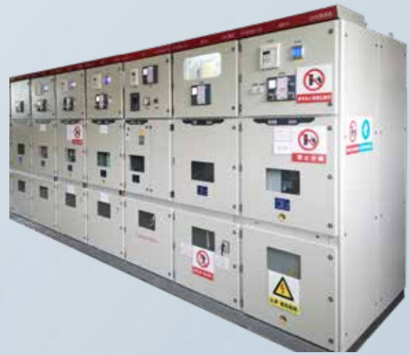
10KV中压KYN28A-12系列
