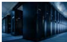
数据中心电力室、电池室
