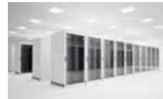
中、小型数据中心
