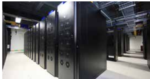
配套背板式多联风冷型精密空调
