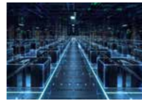
大型数据中心
