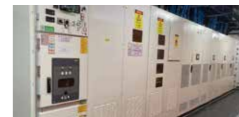
某大型云服务提供商内蒙数据中心
