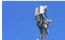
通信机房、基站
