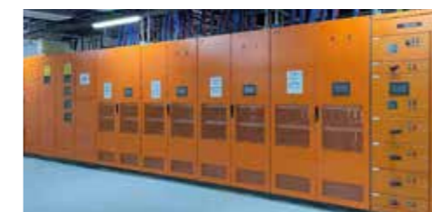
某大型云服务提供商杭州数据中心
