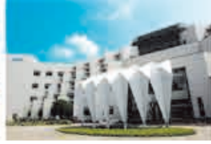
台南研發中心 (鑽石級綠建築)
